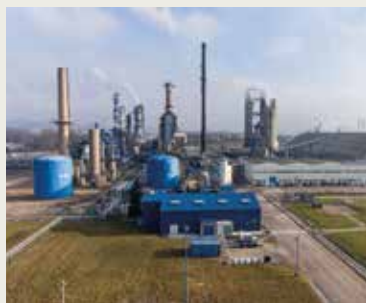
SITE DE PRODUCTION DE SOLUTIONS INDUSTRIELLES
