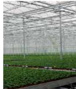
Figure 5 : Alimentation en chaleur et CO 2 des serres à proximité de Yara Sluiskil.
